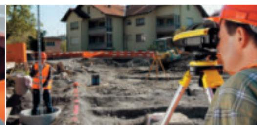
Comprobación de elevación, inclinación y de nivelación de superficie. Determinación de volumen de movimiento de tierras
